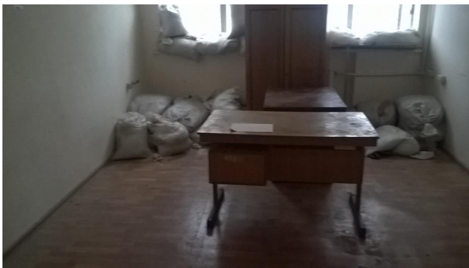
Оглянуте моніторами приміщення в колишній конторі Лисичанського складозаводу
