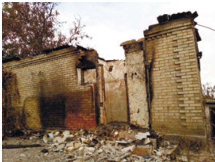
Разрушенный дом в поселке Зайцево Бахмутского района Донецкой области. Автор – местный житель В., пожелавший остаться анонимным. 2017 год
