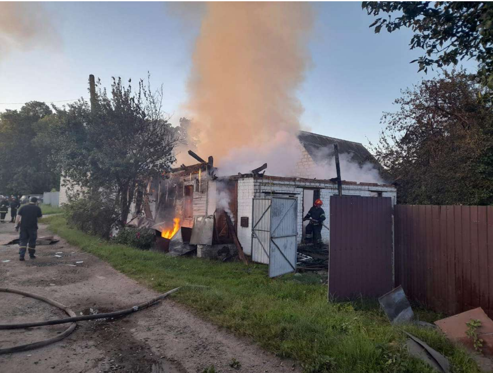
Ліквідація пожежі в приватному житловому будинку, що постраждав від мінометного обстрілу. Середина-Буда, 19.06.22. Джерело фото: Сумська обласна прокуратура
