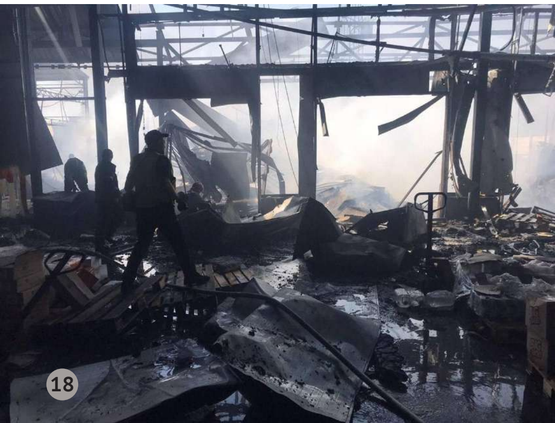
Наслідки обстрілу Харкова, 21.06.22. Поліція обстежує зруйновану будівлю. Фото: Сергій Болвінов. Джерело: Сергій Болвінов (начальник СУ ГУ НП в Харківській області)
