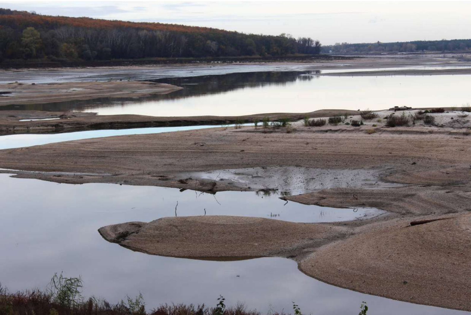
Оскільське водосховище після руйнування дамби. Джерело фото: Суспільне
