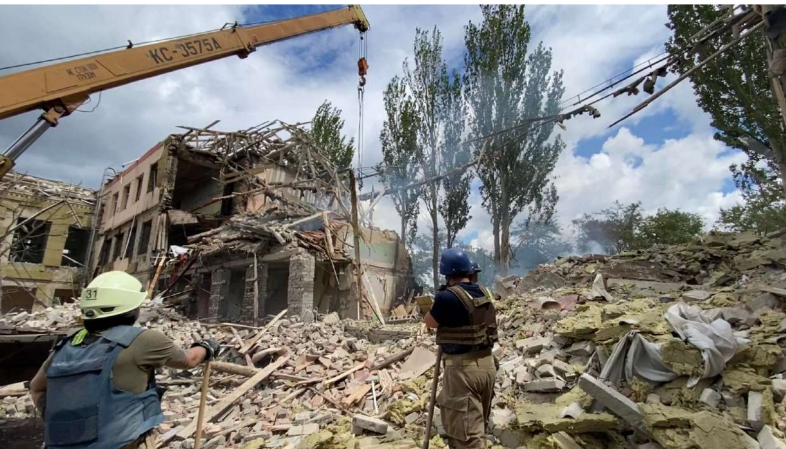
Зруйнована будівля школи в Краматорську, 22.07.2022. Джерело фото: ГУ ДСНСУ у Донецькій області
