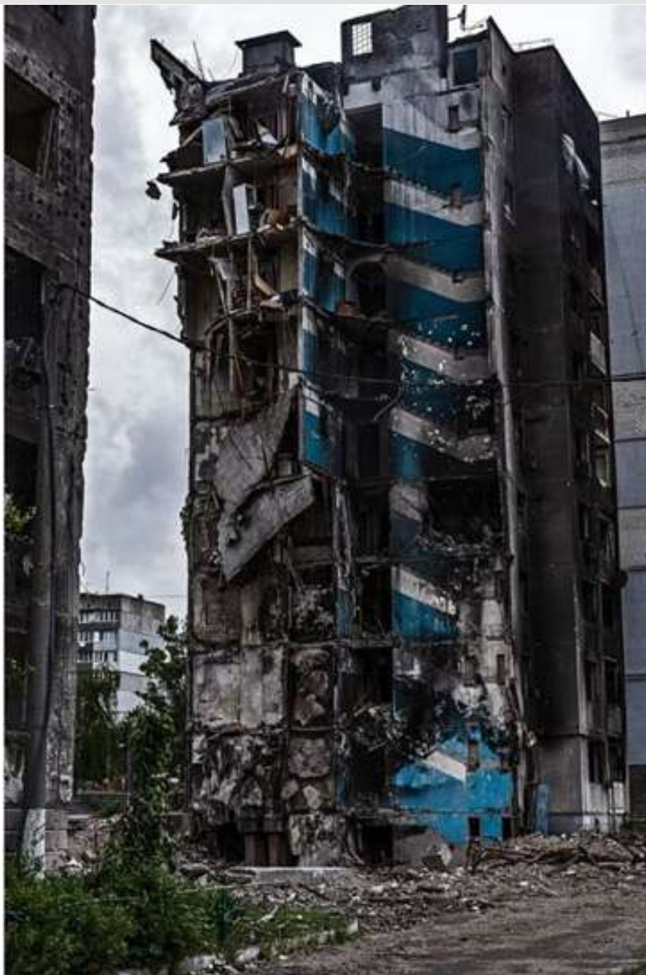
Руйнування житлового будинку, Київщина. Фото: Ines MadDel
