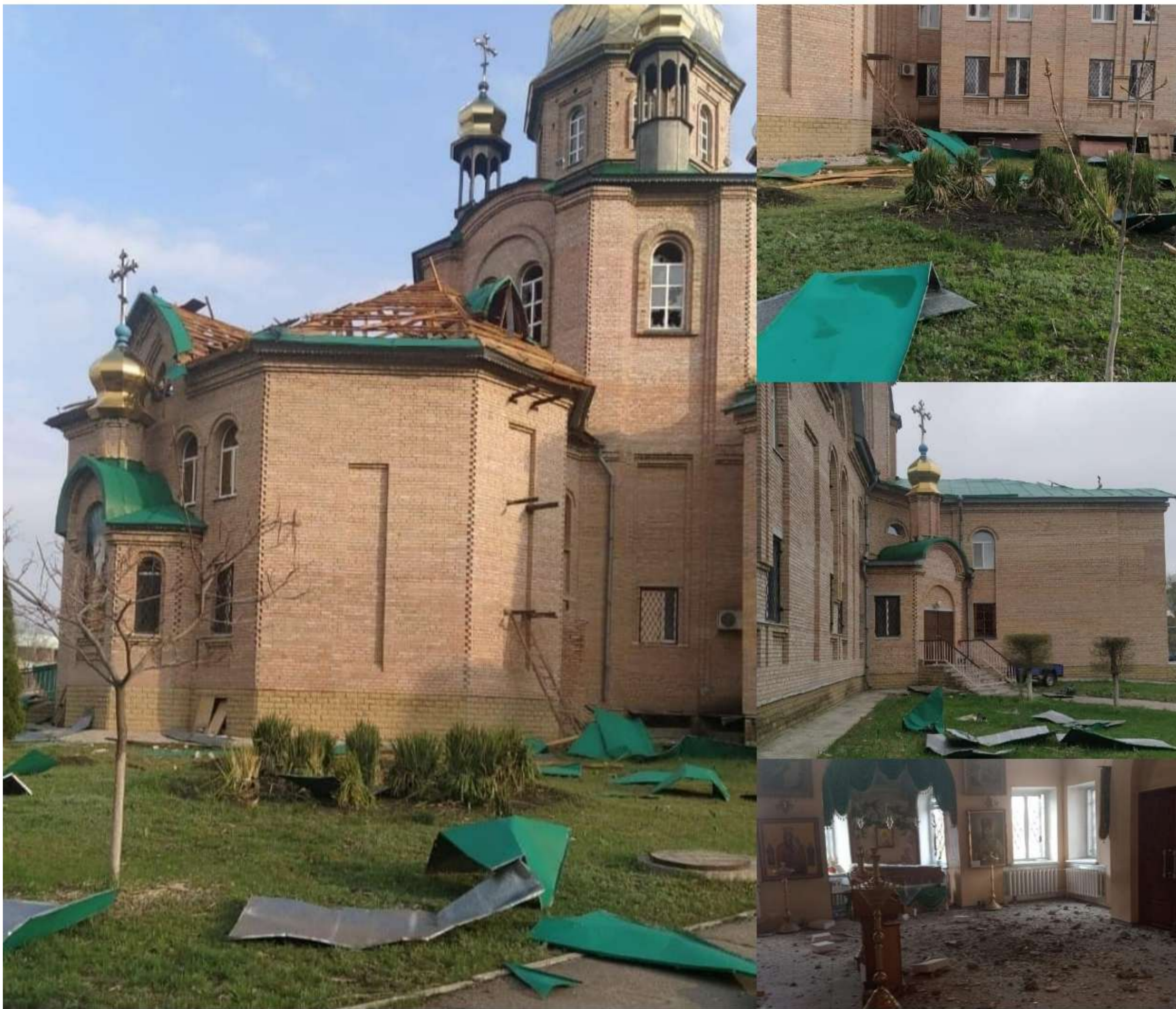
Наслідки артобстрілу будівлі собору в Северодонецьку (Луганська обл.), фото: Сергій Гайдай, 17.04.22
