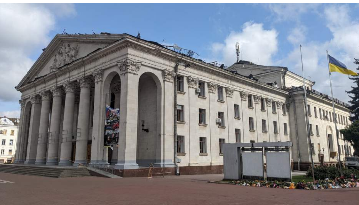
Пошкоджена ракетним ударом будівля театру в Чернігові, 22.08.2023. Джерело фото: СЦГП
