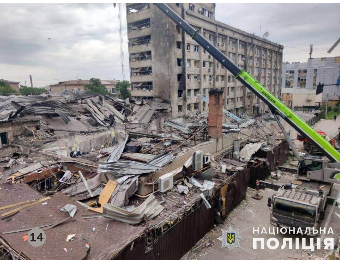
Зруйнована ракетним ударом будівля кафе в м. Краматорську, 27.06.2023. На задньому плані – будівля готелю «Краматорськ». Джерело фото: Національна поліція України.
